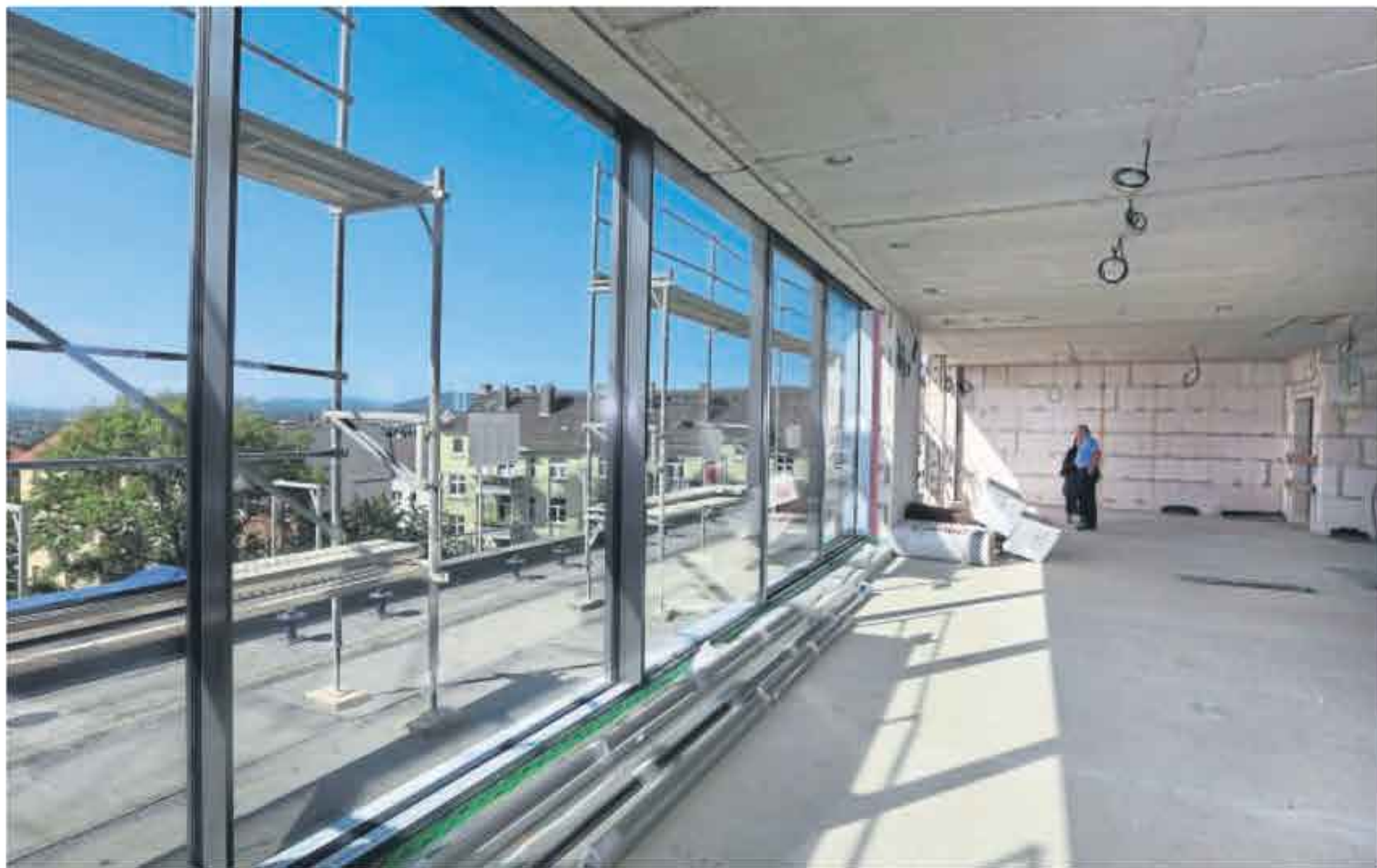
Begehrte Wohnlage: Wohnungen im Martini-Quartier wie hier im Riegel an der Emmerichstraße finden zurzeit problemlos Eigentümer. Die neuen Bewohner können schon in weniger als einem Jahr einziehen. FOTO: DIETER SCHACHTSCHNEIDER
